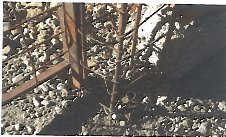
Foto N° 3– Enfierradura del pilar no se conecta con el sobrecimiento contiguo.
