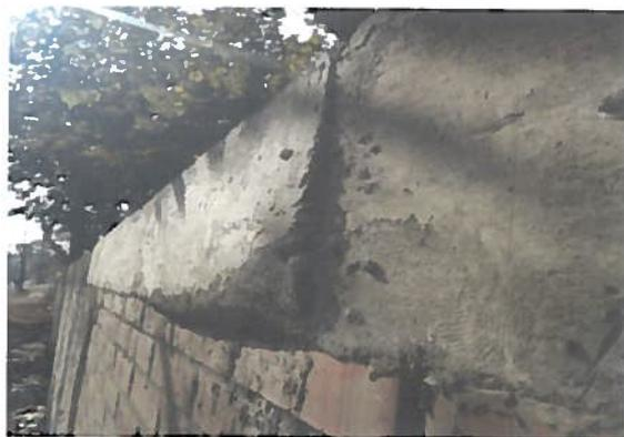
Foto N°5 – Desaplome y superficie irregular cadena hormigón.
