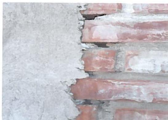
Foto N°7 – Colocación deficiente de mortero de pega de la albañilería.
