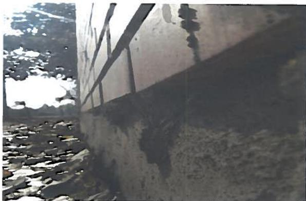
Foto N°4 – Desaplome albañilería y sobrecimiento.
