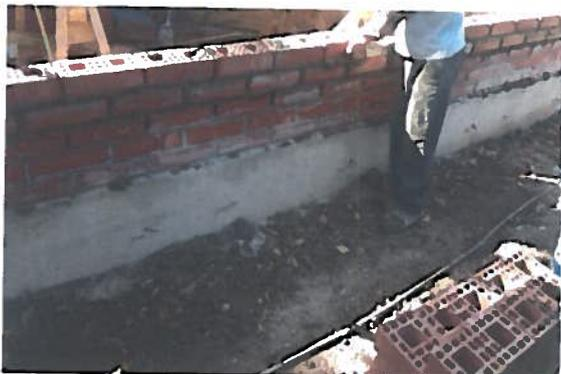
Foto N° 1 – Colocación de ladrillo sin remojar.
