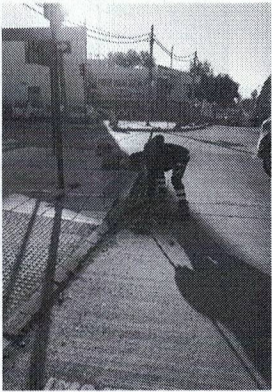
LIMPIEZA Y RETIRO ELEMENTOS EN BNUP QUE OBSTRUYAN LIBRE FLUJO DE AGUAS.
